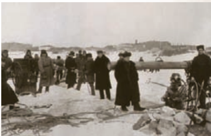
Прокладка водопроводной трубы
