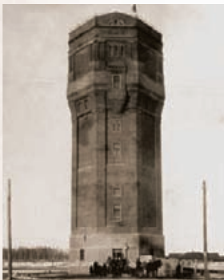
Водонапорная башня. Сохранилась до сих пор
