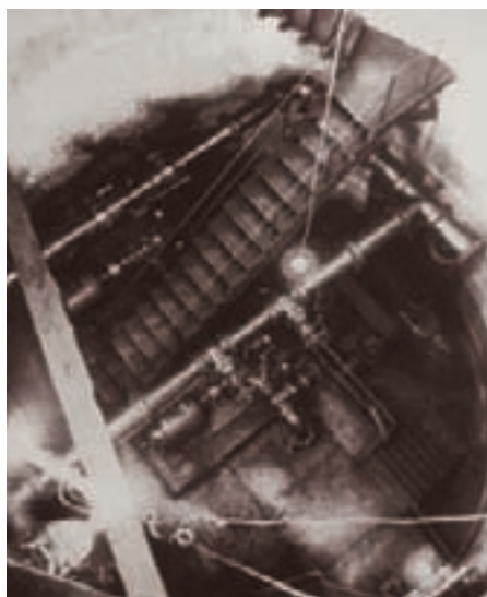
Машинный зал – вид сверху
