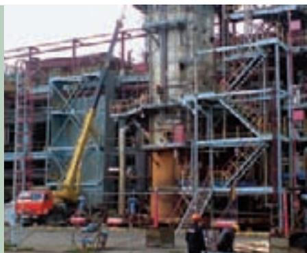
Демонтаж-монтаж трубопроводов и капитальный ремонт ЦГФУ. Тобольский НХК
