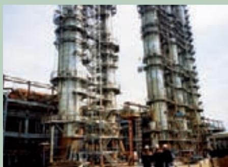
Реконструкция колонн ЦГФУ, замена обменных устройств внутри колонн на Тобольском нефтеперерабатывающем заводе
