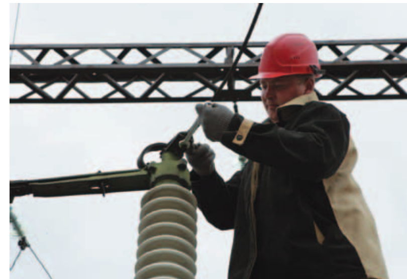
Ремонты идут по плану. Большереченский РЭС «Омскэнерго»
