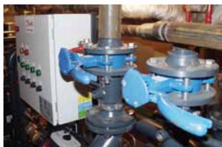
Тепловой пункт заводского изготовления компании ДАНФОСС
