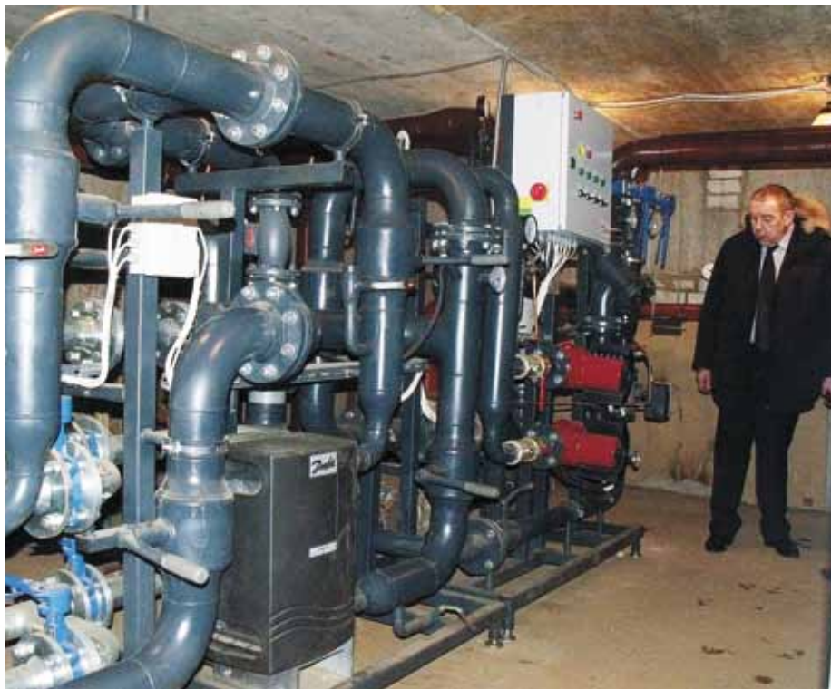
Тепловой пункт заводского изготовления компании ДАНФОСС
