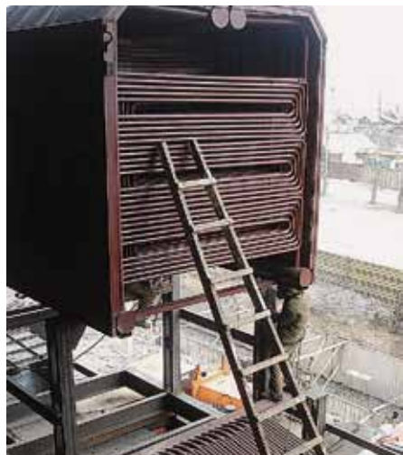
Монтаж конвективного блока
