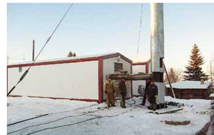
Новый котельный модуль ЦРБ
