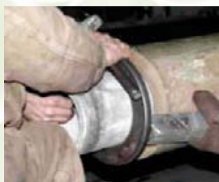
Укладка теплотрассы из асбестцементных труб взамен стальных (поселок АМЗ (автоматно-механического завода) в Челябинске)
