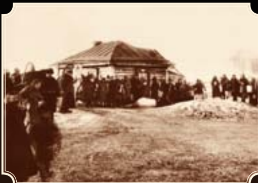
Открытие водоразборной калонки
