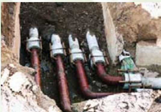
Укладка теплотрассы из асбестцементных труб взамен стальных (поселок АМЗ (автоматно-механического завода) в Челябинске)
