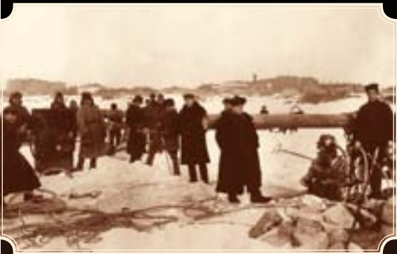
Прокладка водопроводной трубы
