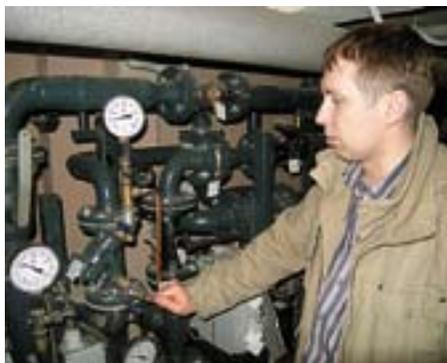
**Константин НАГРЕБЕЦКИЙ, директор подрядной организации ООО «Агентство инженерных решений»:** На данном объекте вся работа, а именно: замена элеваторного узла на автоматизированный узел управления ДАНФОСС, замена систем отопления с установкой регуляторов температуры теплоносителя ДАНФОСС, водопровода и канализации – была сделана за 3 месяца. Работы были начаты в августе. Непосредственно автоматизированный узел управления был установлен и подключен за 2 недели, вкл. пусконаладку.
