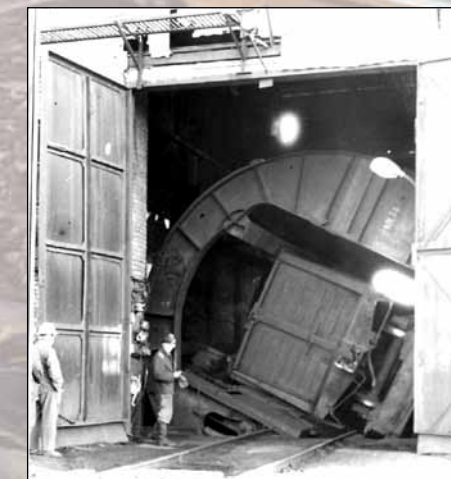
Выгрузка угля на ТЭЦ с помощью вагоноопрокидывателя
