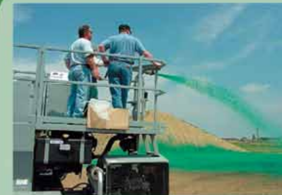
гидропосев газонной травы от 50 р/кв.м
