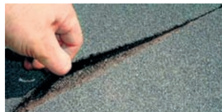
Рис. 7. Относительно тонкий кровельный материал (около 3 мм с посыпкой) наклеивался с применением газовых горелок. Из-за боязни вызвать пережог кровельные материалы были недостаточно прогреты, что вызвало некачественное склеивание
