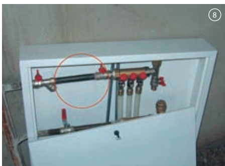
Отсутствует автоматическая балансировка!
