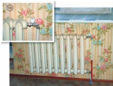
Отсутствует автоматическая балансировка!
