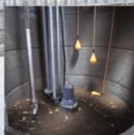
Погружная установка на автоматической трубной муфте
