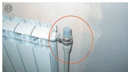
Все терморегуляторы смонтированы головкой вверх. Это НЕПРАВИЛЬНО!
