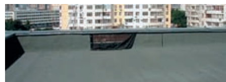
Рис. 8. Сползание кровельных материалов с парапета при их нагревании солнечным теплом
